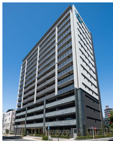
プレサンスロジェ 神戸ポートアイランド (神戸市/ファミリーマンション)
